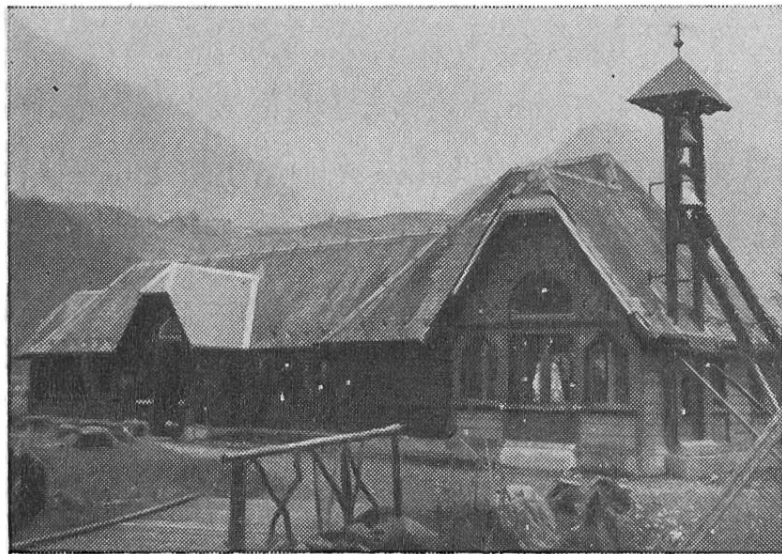
Notkirchlein in Mitlödi
