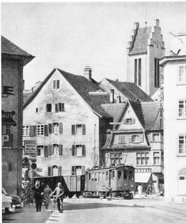
Abb. 17–19 Frauenfeld. Rathausplatz, durchfahren von der 1887 in Betrieb genommenen Strassenbahn Frauenfeld–Wil, welche 1920–1921 elektrifiziert wurde. Nordosteingang des Platzes mit Postgebäude von 1897–1898, Photo um 1900. Pferdpostkurse nach Stammheim, Oberneunforn, Lustdorf und Lanzenneunforn vor dem Postgebäude, Photo um 1900. Südeingang des Platzes von der St. Gallerstrasse her, Photo von Hans Baumgartner um 1958.
