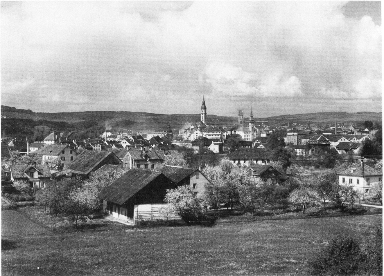
Abb. 21 Frauenfeld von Südwesten. Im Vordergrund die Walzmühlestrasse mit dem Haus Nr. 31. Photographie um 1910 des Postkartenverlages Karl Künzli (Zürich).
