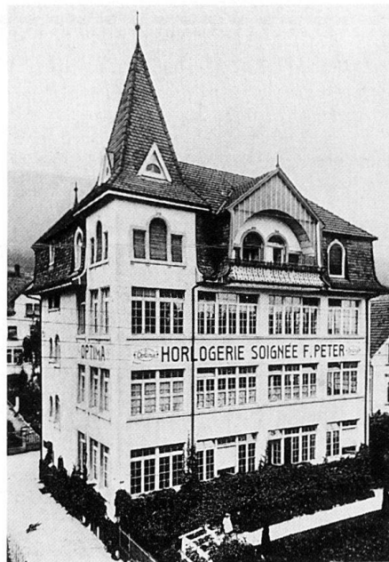
Abb. 32 Grenchen. Uhrenfabrik von Franz Peter, Viaduktstrasse Nrn. 5–7, erbaut 1916–1917 von Otto Rudolf Stalder (vgl. Abb. 17), Photo um 1920.
