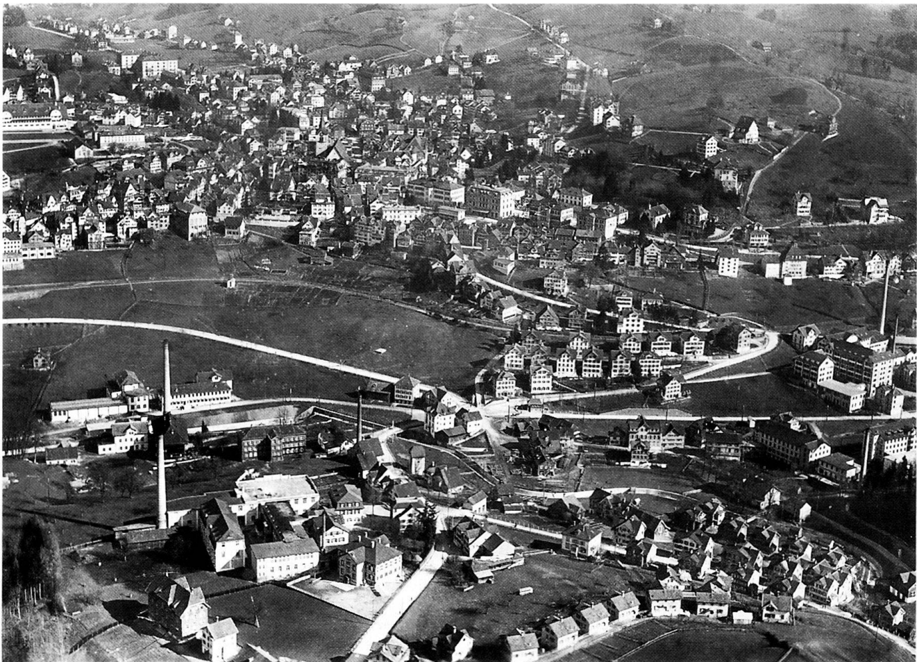
Abb. 39 Herisau. Industriequartier Mühle an der Glatt. Im Vordergrund Mitte die Degersheimerstrasse, im Mittelgrund von rechts nach links Industriestrasse–Cilanderstrasse, darüber die Neue Steig, welche zum Zentrum hinaufführt. Flugaufnahme von Walter Mittelholzer 1921.
