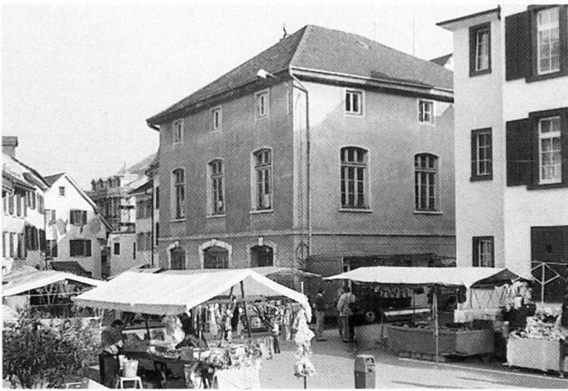
Abb. 27 Liestal. Gemeindehaus am Fischmarkt, erb. 1872–1874. Freistehender Neubau in der Altstadt. Photo 1989.
