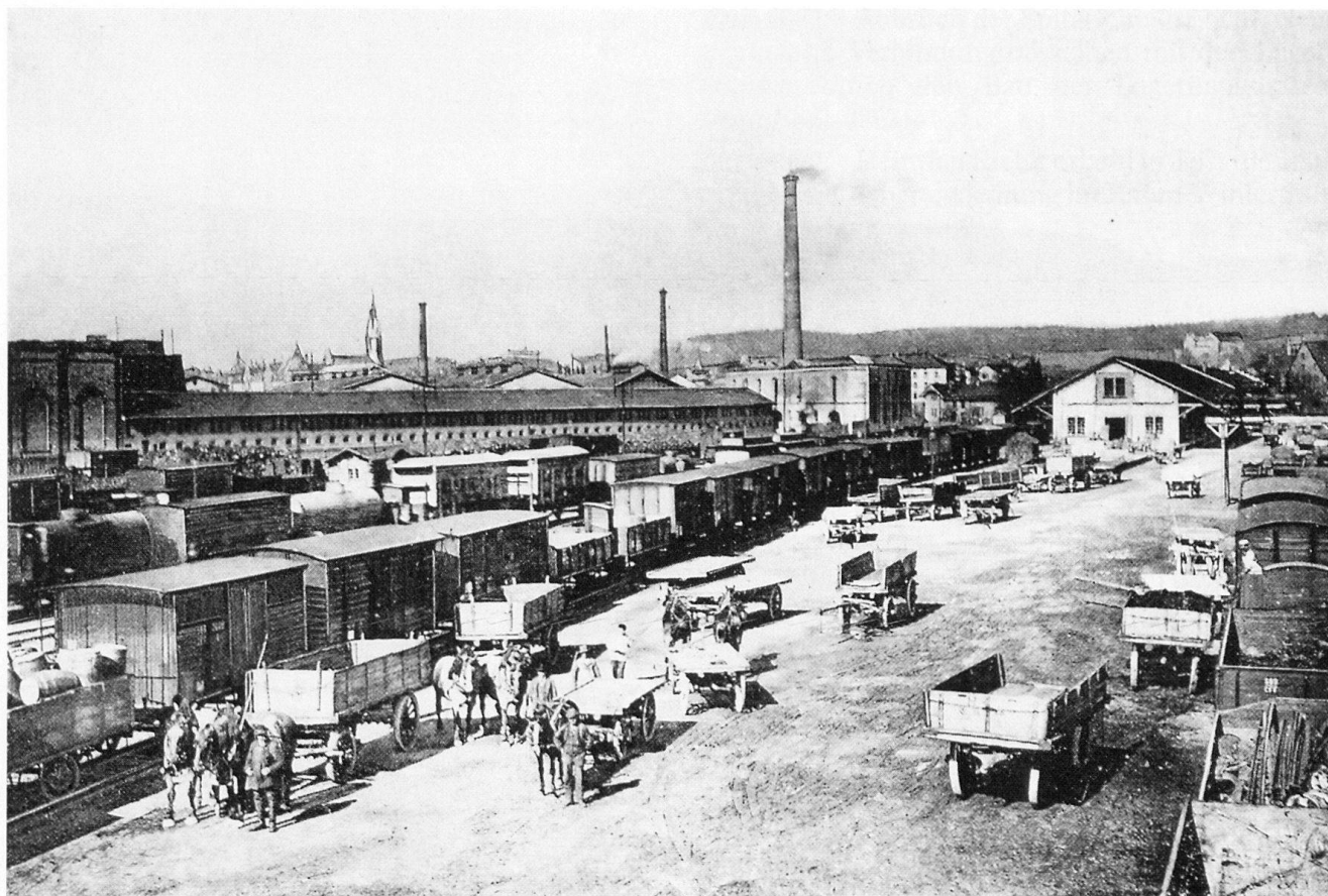
Abb. 5 Winterthur. Der Güterbahnhof an der Unteren Vogelsangstrasse. Hinten rechts der Güterschuppen; hinten links die Bauten der Giesserei und Maschinenfabrik Gebr. Sulzer. Fotografie um 1900–1905.
