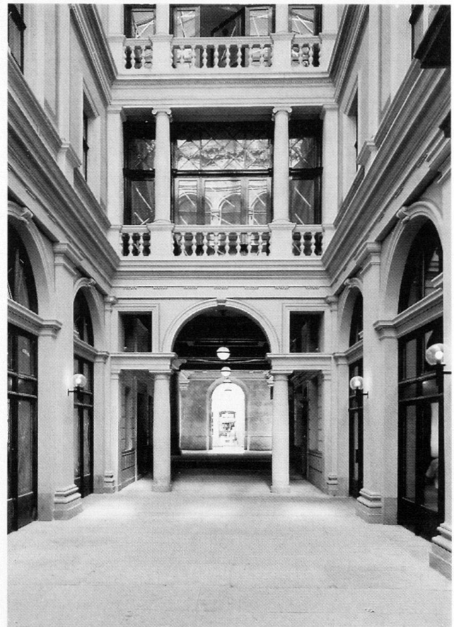
Abb. 33 Winterthur. Rathauspassage zwischen Stadthausstrasse und Marktgasse, erbaut 1872–1874 von Joseph Bösch.
