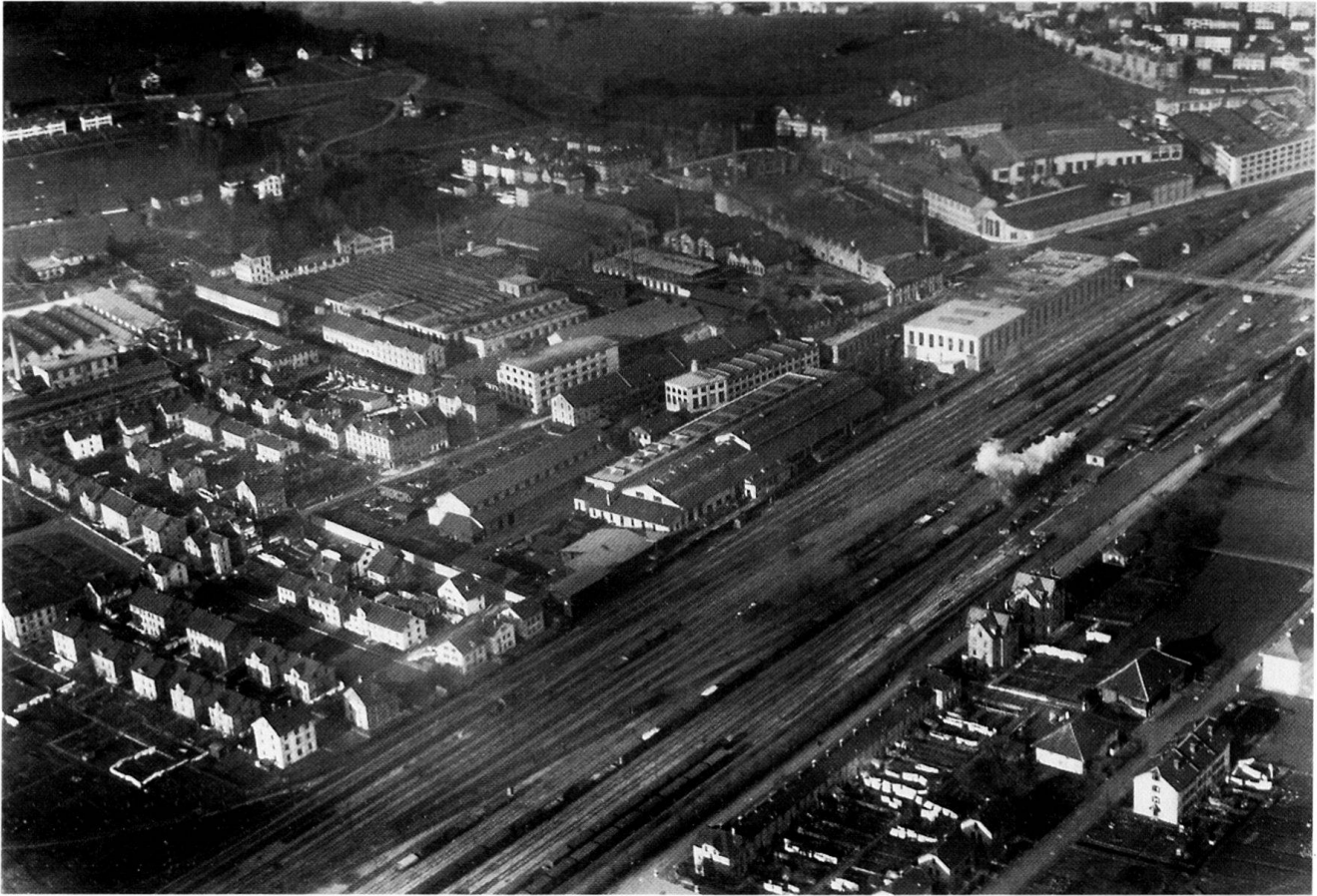
Abb. 65 Winterthur. Luftaufnahme von Süden, 1923. Tössfeldquartier mit den Bauten der Giesserei und Maschinenfabrik Gebr. Sulzer (oben rechts und Mitte) und denjenigen der Schweizerischen Lokomotiv- und Maschinenfabrik (Mitte oben und links). Rechts unten die Arbeiter-Einfamilienhauszeile der Gesellschaft für Erstellung billiger Wohnhäuser im Unteren Vogelsang, erbaut 1891-1892; links oben das Brühlbergquartier.
