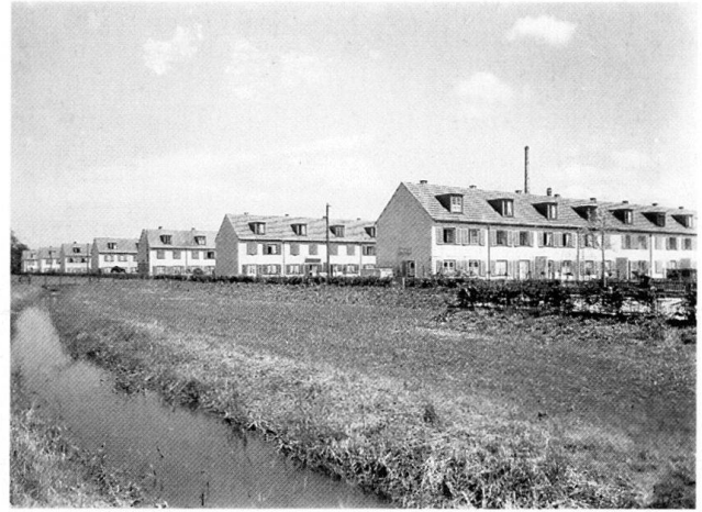
Abb. 55 Winterthur. Einfamilien-Reihenhäuser der Kolonie «Selbsthilfe» im Oberen Deutweg, erbaut 1925–1929 von Adolf Kellermüller, Franz Scheibler und Arthur Reinhart.
