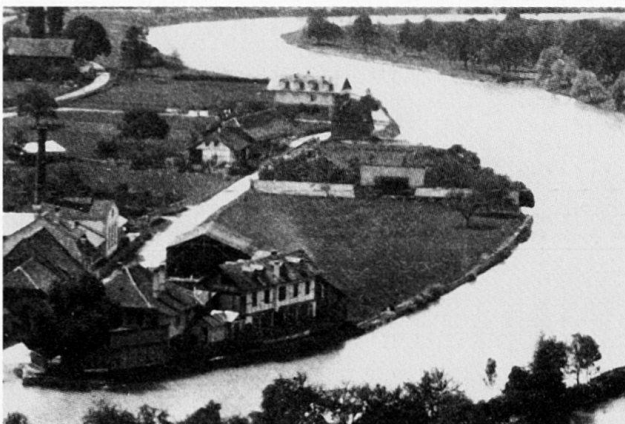
Abb. 49 Areal an der Scheibenstrasse ; am linken Bildrand das Gaswerk (Nr. 13), im Vordergrund die ehemalige Gewehrfabrik von Erlach & Co. (Nr. 4). Fotografie um 1865.
