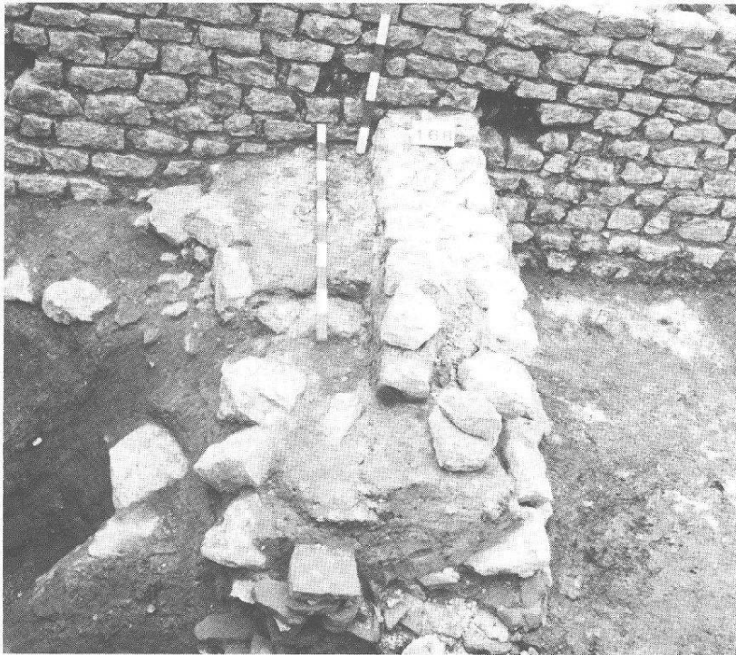
Abb. 17 Augst, Parz. 76.11, H. Falk, Ins. XXIX. Trennmauer zwischen dem nördlichen und dem südlichen Insulabereich. Ansicht von Nordwesten.
