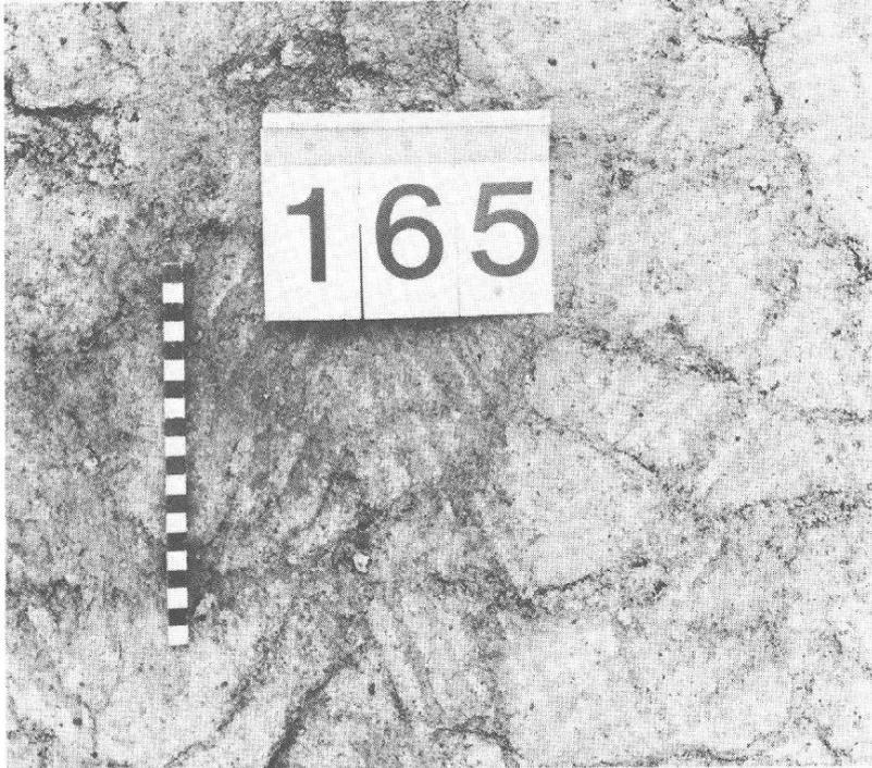
Abb. 10 Rückseite der umgekippten Verputzwand mit Abdrücken der fischgrätartig angeordneten, stabförmigen Putzträger.
