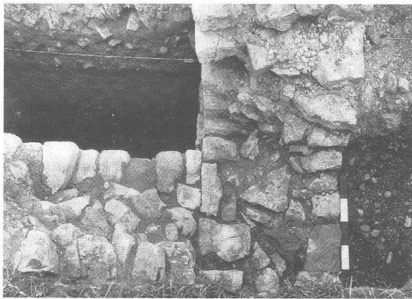
Abb. 7 Augst-Forum. Mauer 4 (links) stösst an Mauer 6.
