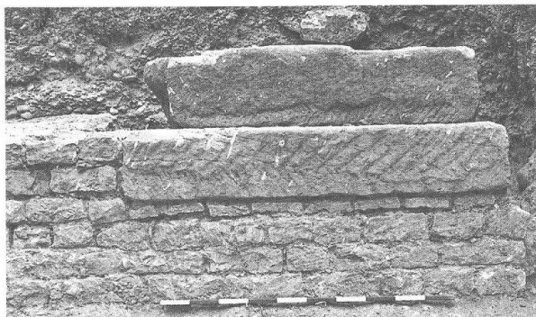
Abb. 44 Augst-Amphitheater 1988. Östlicher Abschluss der Hangstützmauer MR13 mit Sandsteinstufen. Blick von Süden.
