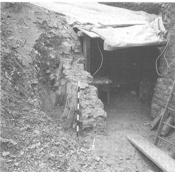
Abb. 17 Augst BL, Grabung 1965–1967.52 (Abb. 2,15). Überrest der in Phase III vom Graben 3 durchschlagenen (Treppen-)Hausmauer der Taberne (Abb. 25, MR 11). Blick nach Süden.
