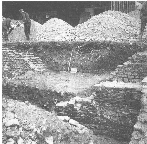
Abb. 18 Augst BL, Grabung 1971.55 (Abb. 2,16). Blick auf verschiedene in Phase III vom Graben 3 durchschlagene Mauern im Innern der Insula 9. Blick nach Osten.
