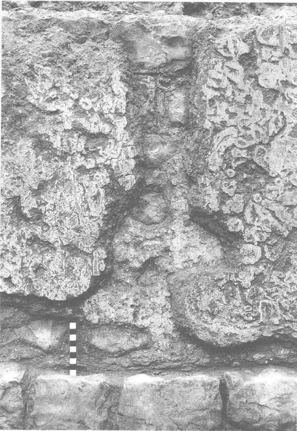
Abb. 67 Augst BL, Grabung 1990.51, Fläche 3. Ausschnitt von Abb. 66 mit Verputz des 2. Theaters an der Umfassungsmauer 3 des 1. bzw. 2. Theaters. Er zeigt den schwach erkennbaren Fugenstrich am Bruchsteinmauerwerk der Umfassungsmauer 3, die Verputzreste des 1. Theaters (Phase 4) und darüber den in Phase 10 aufgetragenen Wandverputz des 2. Theaters.
