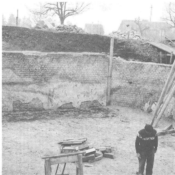
Abb. 21 Augst BL, Grabung 1961.60. Blick vom Inneren der Curia auf die Innenwand der Curiamauer (MR 1). Der massive Senkungsriiss ist auf das Unterhöhlen des Curiafundamentes beim Bau der jüngeren Basilika-Stützmauer zurückzuführen. Er ist heute durch moderne Restaurierungsarbeiten weitgehend beseitigt worden. Photo von den Restaurierungsarbeiten; Blick nach Norden.
