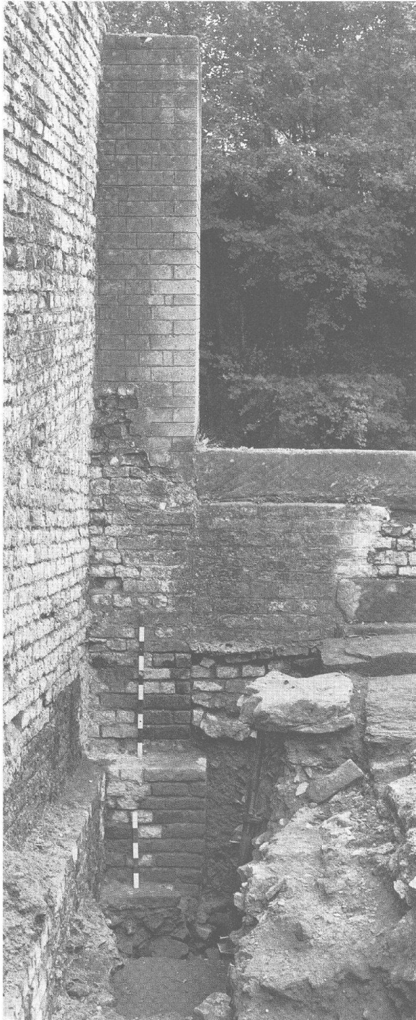
Abb. 22: Augst, Theatersanierung (Grabung 1997.55). Südaditus und südliche Eingangshalle. Blick von Norden in den Südaditus. Links die östliche Aditusmauer (MR 43) mit dem grösstenteils rekonstruierten, vorspringenden Gurtpfiler; auf der rechten Bildhälfte die Sandsteinschwelle der jüngsten Bauperiode. Unter diesen Mauerzügen, durch einen Absatz markiert, die Überreste älterer Bauphasen, vermutlich des Amphitheaters.
