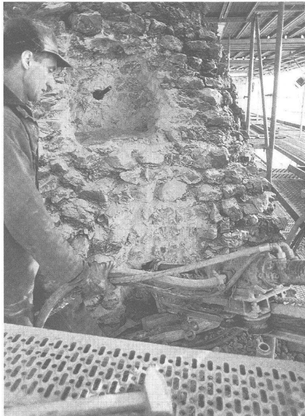
Abb. 40: Augst, Theatersanierung (Grabung 1997.55). Nördliche Cavea-Abschlussmauer (MR 60). Bohrmeister in Aktion. Die Löcher für die Erdanker werden an genau bezeichneten Punkten mit einer Neigung von 15° quer durch die moderne Vormauerung und das Originalmauerwerk bis tief in die Keilfüllung vorgebohrt.
