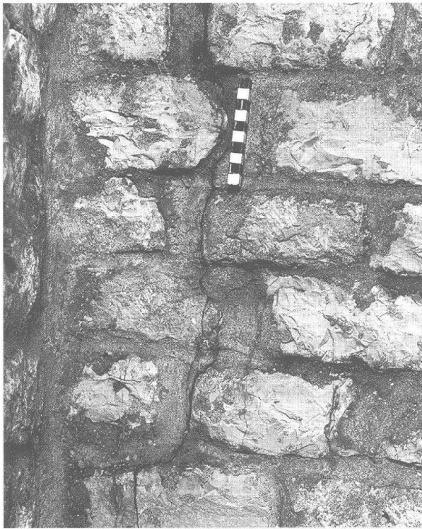
Abb. 39: Augst, Theatersanierung (Grabung 1997.55). Nördliche Cavea-Abschlussmauer (MR 60). Detail mit vertikal durch mehrere Steinschichten verlaufendem Riss in einem Entlastungsbogen. M. 1 : 5.
