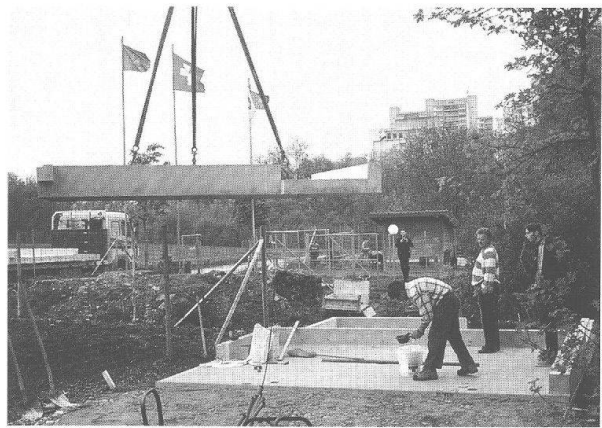
Abb. 14: Augst, Osttorareal (Grabung 1998.56), Befundzone 2 (Trakt für Esel und Futtervorräte). «Bauen über den Ruinen»: Das Verlegen der vorfabrizierten Fundamentplatten auf die Micropfähle und die vorbereitete Humusschicht (im Vordergrund und Abb. 13).
