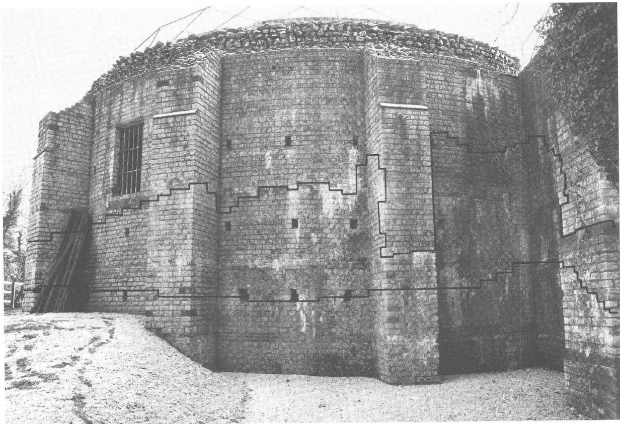
Abb. 6: Augst BL, Curia-Schutzdach (Grabung 1998.51). Ansicht der Curia von Norden nach der Wiederherstellung der Umgebung zum Schluss der Arbeiten. Die untere Linie markiert die Terrainoberfläche im Jahr 1941 vor den Abgrabungen durch R. Laur-Belart. Die obere Linie bezeichnet den ungefähren Höhenverlauf, ab der die Mauerschale erneuert wurde.
