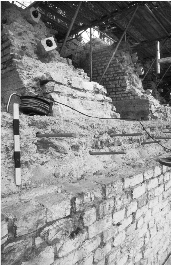
Abb. 36: Augst, Theatersanierung (Grabung 2004.055). Peripheriebereich Keil 3 (MR 58): Ins Mauerwerk eingebohrte Glasfaseranker und -dübel garantieren die Verbindung zwischen dem bestehenden Mauerkörper und den Vor- und Aufmauerungen der aktuellen Sanierungskampagne.
