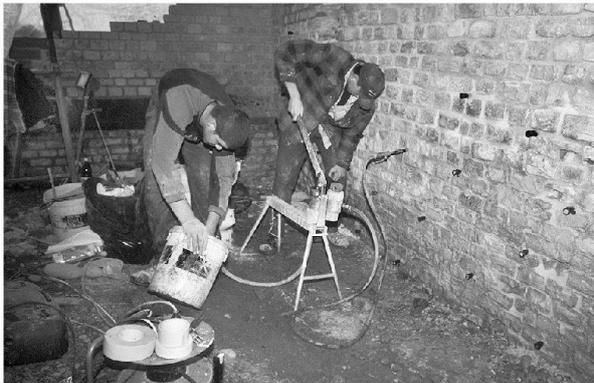
Abb. 47: Augst, Theatersanierung (Grabung 2004.055). Peripheriebereich Keil 4 (MR 58): Einpumpen des Injektionsmörtels in die Mauerkluff; an der Handkolbenpumpe arbeiten Dominik Fux und Mubekir Hajrzi. Blick von Osten, im Hintergrund Pfeiler MR 196.
