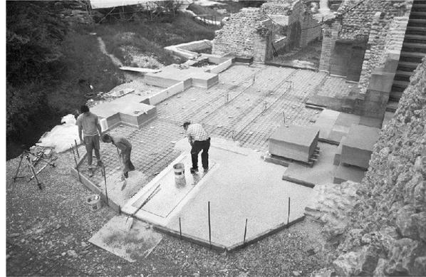
Abb. 28: Augst, Theatersanierung (Grabung 2004.055). Ausgestaltung der Bodenbeläge: Einbringen des hellen Bodenbelags im Bereich der ehemals durch ein Tonnengewölbe überspannten Südhalle. Zur Stabilisierung wird im Bodenbelag ein leichtes Eisennetz eingelegt. Übersicht von Südosten.
