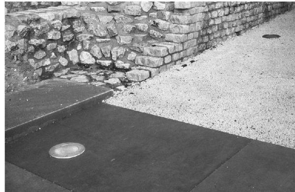
Abb. 30: Augst, Theatersanierung (Grabung 2004.055). Ausgestaltung der Bodenbeläge, Mittelvomitorium: Die Bodenlampen sind in die Bodenbeläge integriert. Blick vom Diazoma-Umgang gegen Nordosten.
