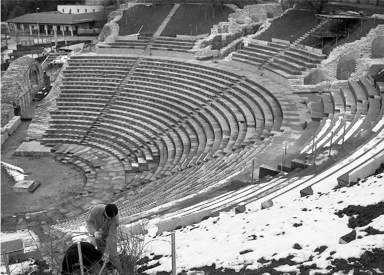
Abb. 23: Augst, Theatersanierung (Grabung 2004.055). Rekonstruktion des Sitzstufenbereichs: Im frisch mit Erde angeböschten Bereich des zweiten Sitzstufenrangs zeichnen sich die Stimmbretter der Treppenläufe, die im oberen, nicht mit Sitzstufenkörben rekonstruierten Teil von Rang 2 provisorisch erscheinen sollen, noch überdeutlich ab. Blick von Osten.
