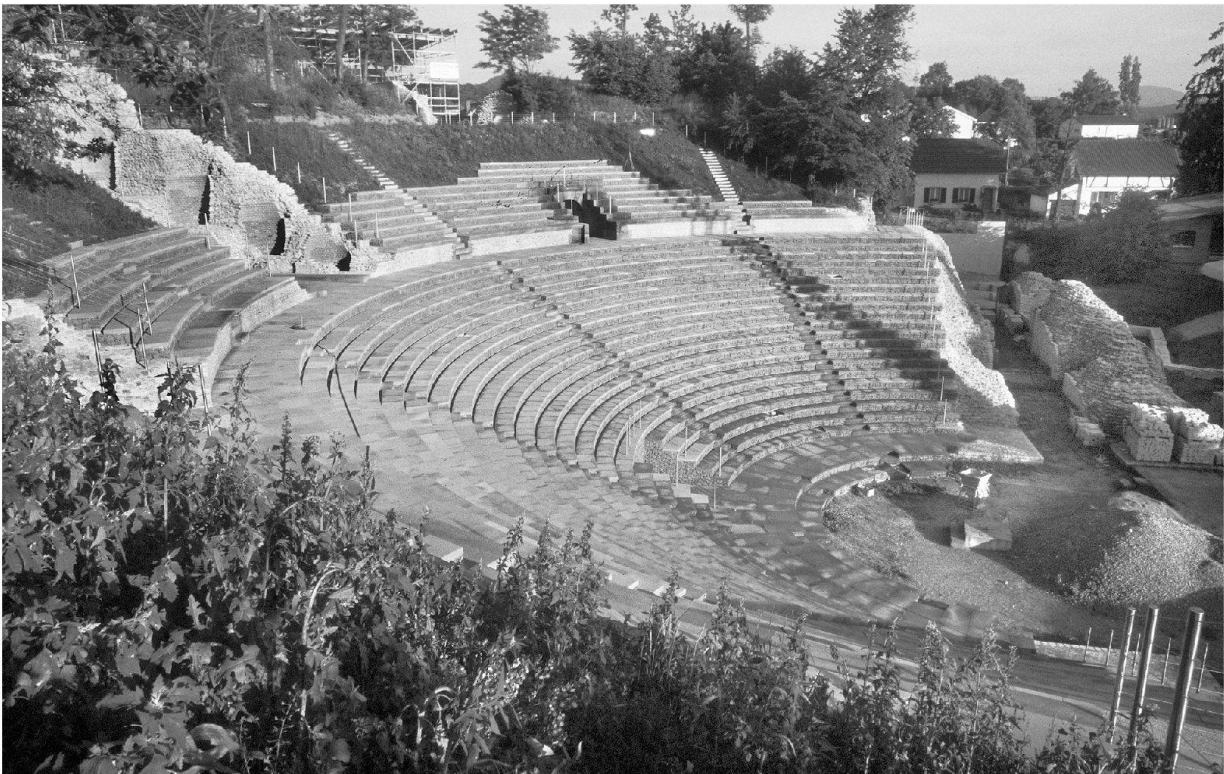
Abb. 24: Augst, Theatersanierung (Grabung 2004.055). Rekonstruktion des Sitzstufenbereichs: Nach der Begrünung des zweiten Sitzstufenrangs reduziert sich die Dominanz der oberen Treppenläufe. Übersicht von Norden.
