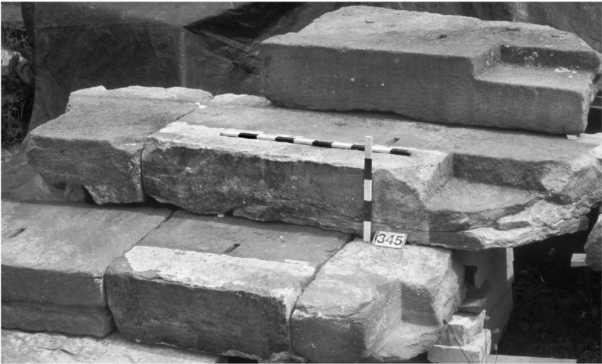
Abb. 12: Augst, Theatersanierung (Grabung 2001.055). Grundlagen zur Erarbeitung eines Auswertungskonzepts. Architekturprobe der cavea des jüngeren szenischen Theaters, unter Verwendung originaler Sitzstufenquader aus Buntsandstein.
