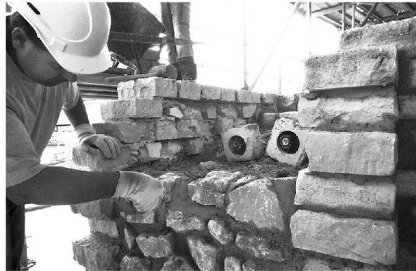
Abb. 37: Augst, Theatersanierung (Grabung 2004.055). Peripheriebereich Keil 3 (MR 58): Die Schraubenmutter der Glasfaseranker werden in den Mauerkern integriert. Maurer Agim Delija beim Erstellen der neuen Kernvor-mauerung.
