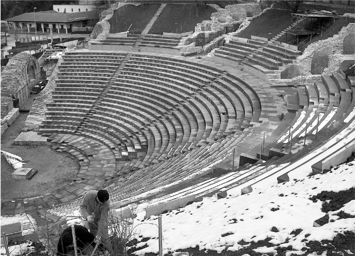
Abb. 23: Augst, Theatersanierung (Grabung 2004.055). Rekonstruktion des Sitzstufenbereichs: Im frisch mit Erde angeböschten Bereich des zweiten Sitzstufenrangs zeichnen sich die Stimbretter der Treppenläufe, die im oberen, nicht mit Sitzstufenkörben rekonstruierten Teil von Rang 2 provisorisch erscheinen sollen, noch überdeutlich ab. Blick von Osten.
