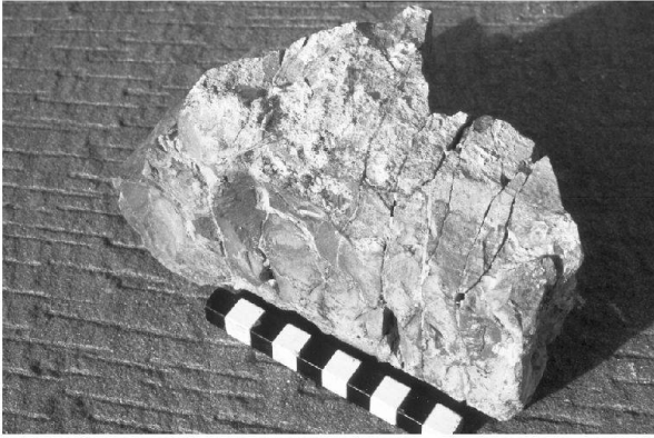
Abb. 31: Augst, Theatersanierung (Grabung 2004.055). Eingangsbereich Mittelvomitorium, MR 168: Ein antiker Schalenquader aus Muschelkalk mit starken Frostschäden wurde im Verlauf der Feinsanierungsarbeiten geklebt. Mit dem erneuten Einbau des Schalenquaders erscheint die Mauer- schale wieder einheitlich und geschlossen, wodurch das Risiko einer erneuten Zerstörung durch Pflanzenbewuchs vermindert wird.
