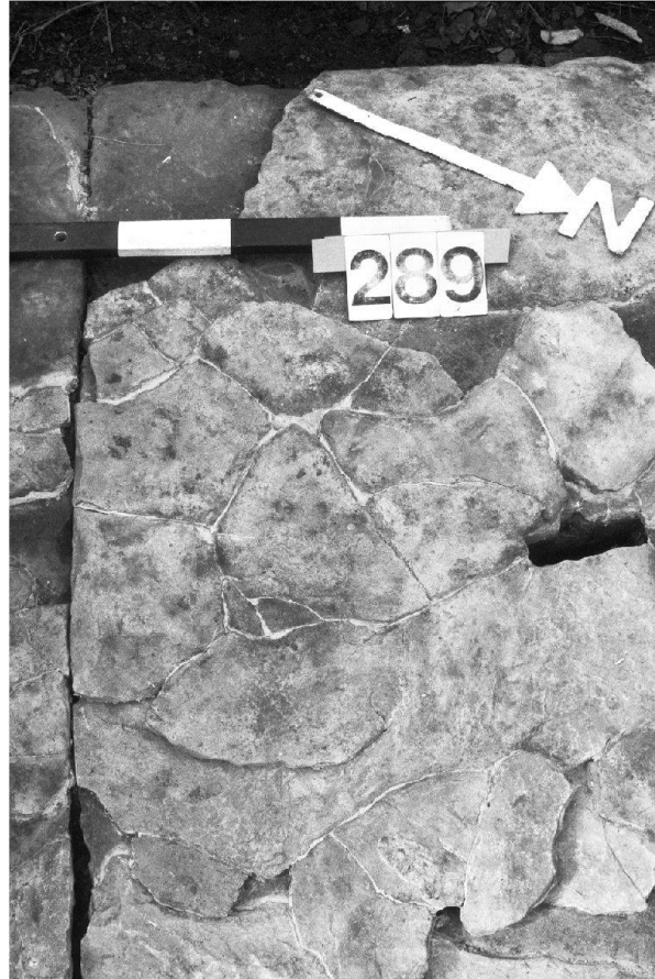
Abb. 32: Augst, Theatersanierung (Grabung 2004.055). Sandsteinschwelle zum Westcarcer (MR 261): Die in vielen Teilstücken abgespaltene Oberfläche des Schwellenquaders aus feinkörnigem Buntsandstein wurde in aufwändiger Feinarbeit restauriert. Die auf der Oberfläche ablesbaren Baudetails können so weiterhin nachvollzogen werden. Im Verlauf der Arbeiten zur Um- gebungsgestaltung wird die Sandsteinschwelle mit Erde überschüttet und so zusätzlich vor mechanischer Abrasion geschützt werden.
