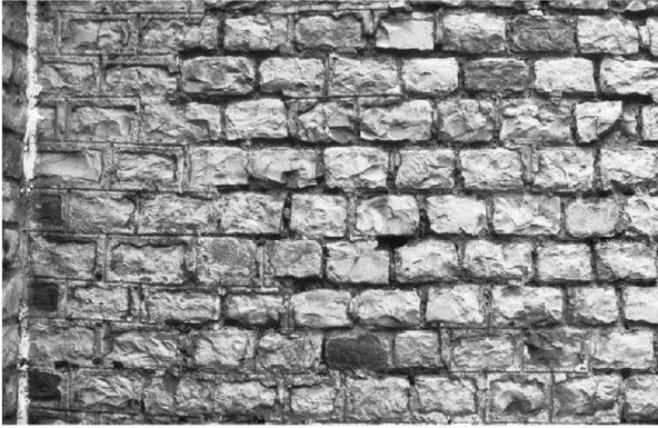
Abb. 43: Augst, Theatersanierung (Grabung 2004.055). Peripheriebereich Keil 4 (MR 58): Ausschnitt der Ansicht an die stark ausgebaute Mauerschale mit rot bemaltem Fugenstrich, Stand vor Beginn der Injektionsarbeiten.
