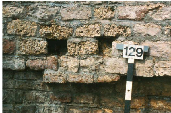
Abb. 37: Augst, Theatersanierung (Grabung 2005.055). Peripherie, Keil 4. Entlastungsbogen MR 141 mit horizontal verschobenem, originalem Kalksteinmauerwerk. Balkenlöcher mit Rundholznegativen im antiken Kalkmörtel; Detail zu Abb. 36.
