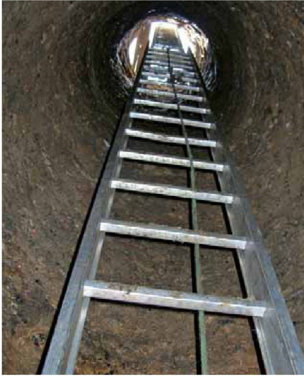
Abb. 22: Kaiseraugst AG, Wacht/Künzli (Grabung 2006.004). Schacht des Sodbrunnens MR 6.
