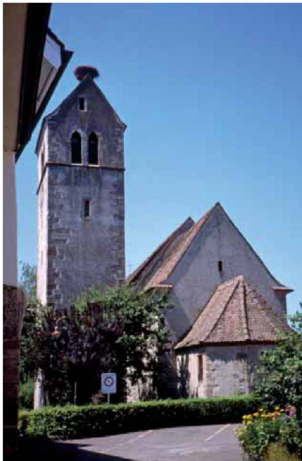
Abb. 29: Kaiseraugst AG, Kirche St. Gallus (Grabung 2006.005). Blick von Südosten.
