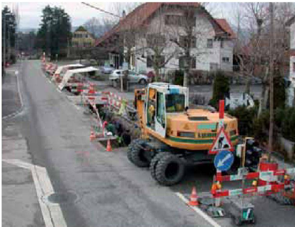
Abb. 9: Augst BL, Leitungsgaben Merkurstrasse (Grabung 2006.053). Blick über die erste Etappe des Leitungsgabens im Bereich der Giebenacherstrasse. Von Südosten.
