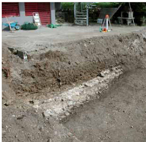
Abb. 13: Augst BL, Neusatz (Grabung 2006.054). Blick von Nordwesten in die Baugrube für das Schwimmbeckenfundament.
