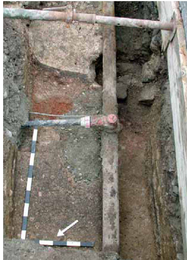
► Abb. 10: Augst BL, Leitungsgaben Merkurstrasse (Grabung 2006.053). Blick in den Leitungsgaben. Im Vordergrund unter dem Nordpfeil der Rest eines Terrazzobodens, im Hintergrund unter der Querstrebe eine Mauer, die von der alten Wasserleitung durchschlagen wird.
