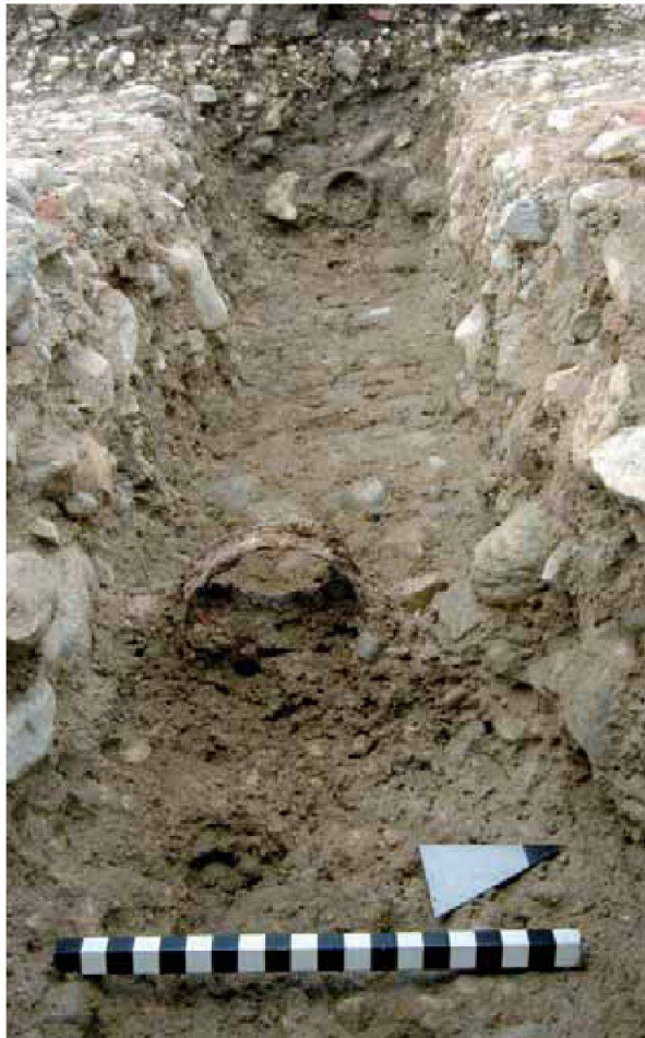
Abb. 7: Augst BL, Obermühle (Grabung 2006.051). Zwei in situ liegende eiserne Teuchelringe einer Frischwasserleitung.
