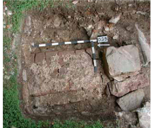
Abb. 17: Augst BL, WC Lapidarium (Grabung 2006.060). Blick auf die aus groben Steinblöcken errichtete Kanalabdeckung. Nach links ist eine hangwärts verlaufende Mauer zu erkennen, die eine aus Ziegelfragmenten bestehende Lage aufweist.
