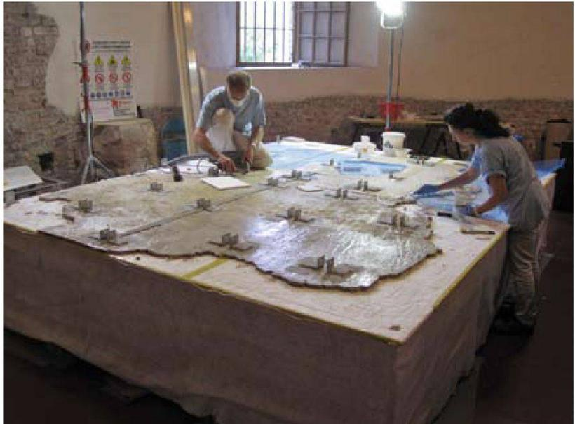
► *Abb. 66: Augst BL, Curia/Mosaikenaussstellung. Wiederum mit vereinten Kräften wurden die beiden neuen Trägerplatten mit dem Mosaik «Palazzo IV» in den inzwischen an der Innenwand des Curiakellers montierten Rahmen eingesetzt und verschraubt.*
