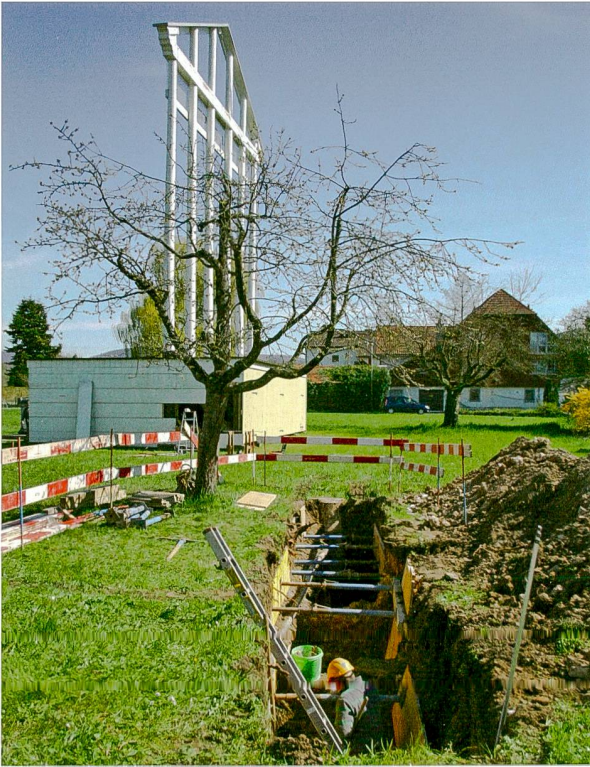
Abb. 39: Augst BL, Forum (Grabung 2015.055). Um die bekannten Befunde zu schonen, wurde der Aushub von Hand durchgeführt. Im Hintergrund die angedeutete Fassade des Forumtempels. Von Nordwesten.
