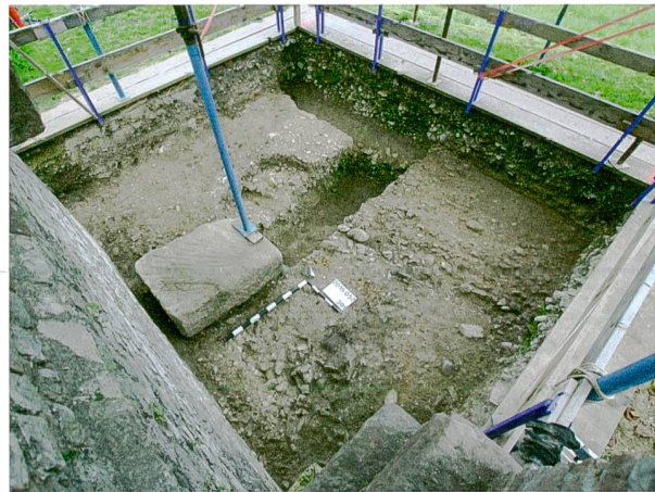
Abb. 63: Augst BL, Basilica-Stützmauern (Grabung 2015.057). In Feld 8 wurden in diesem Jahr die letzten nachrömischen Eingriffe und Schichten beseitigt. Danach präsentiert sich der Kiesbelag der Fielenriedstrasse (oben im Bild), in dem sich Fahrspuren erhalten haben (rechts oben) im nördlichen Feldteil, während im Südteil ein eher unregelmässig strukturiertes Sediment zu sehen ist. Nördlich an den Prallstein für den Wasseraustritt (Rimstein MR 19) aus Mauer MR 18 anschliessend zeigt sich ein Graben, dessen Zeitstellung bisher nicht geklärt ist. Bei seinem Aushub hat man eine durch die Bildmitte quer laufende Teuchelleitung zerstört. Von Süden.
