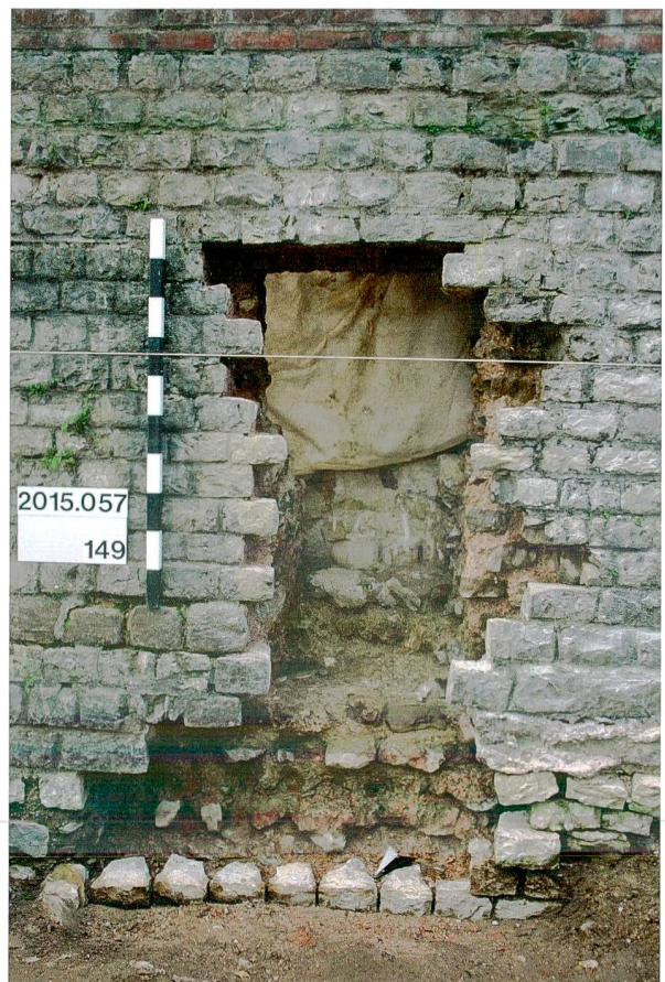
Abb. 60: Augst BL, Basilica-Stützmauern (Grabung 2015.057). Der Mauerdurchbruch von Abbildung 59 nach Abschluss der Sondierung. Die unteren Steinreihen sind Bestandteil von MR 8, was bedeutet, dass MR 14 auf diese aufgesetzt wurde. Von Nordwesten.
