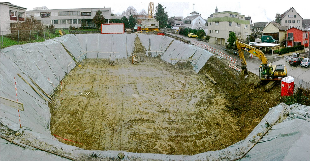
Abb. 24: Augst BL, Hausmatt (Grabung 2015.053). Die erweiterte Baugrube nach den zusätzlichen Aushubarbeiten im Februar 2015. Von Osten.
