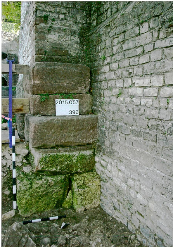
Abb. 66: Augst BL, Basilica-Stützmauern (Grabung 2015.057). Die Nordecke der Basilica-Stützmauer ist baulich sehr exponiert, muss sie doch grosse Lasten (Erd- und Gebäudedruck) abfangen. Dementsprechend ist die Ecke mit MR 20 sehr massiv ausgeführt. Entsprechend wurde das Fundament ausgelegt, von dem durch die Ausgrabungsarbeiten in Feld 8 weitere Steinlagen freigelegt werden konnten. Die verbauten Buntsandstein- und Kalksteinblöcke sind unterschiedlich gross, und es gibt Spuren, die auf eine Zweitverwendung an dieser Stelle hindeuten. Von Nordwesten.
