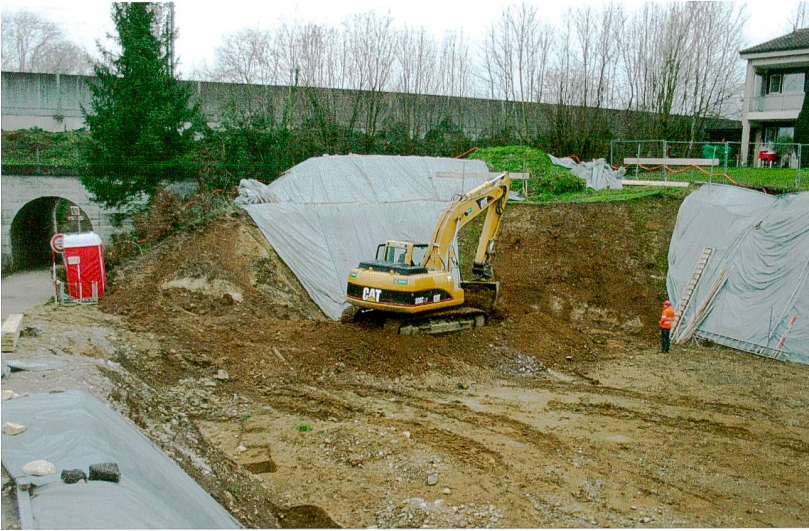
Abb. 22: Augst BL, Hausmatt (Grabung 2015.053). Aushubarbeiten am östlichen Baugrubenrand. Im Hintergrund die Schallschutzwand der SBB-Linie, links die tunnelförmige Unterführung, durch die der Hausmattweg an die Ergolz führt. Von Nordwesten.
