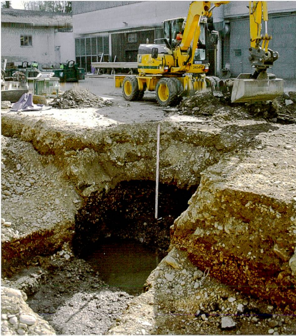
Abb. 34: Augst BL, Werkhof E. Frey AG (Grabung 2015.054). Tief geführter Aushub zur Abklärung der Terrainverhältnisse im westlichen Teil der geplanten Werkhalle. Von Westen.
