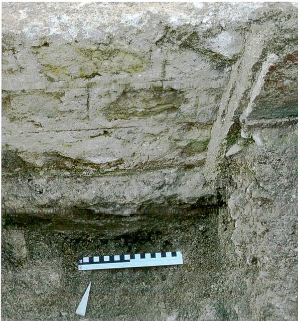
Abb. 21: Kaiseraugst AG, Baugrube Dorfstrasse 29 (Baubegleitung 2015.002). Kleine Sondierung an MR 72, die den Absatz und das sorgfältig mit Fugenstrich versehene Aufgehende zeigt. Die drei Verputzschichten sind hier schön zu sehen. Blick von Süden.
