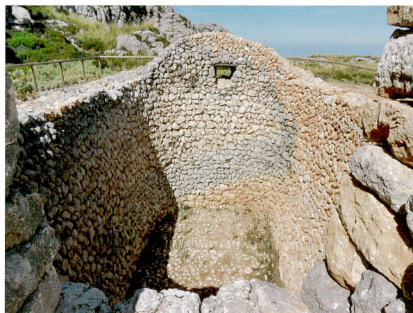
Abb. 15: (Früh-)nezeitliche und moderne Baubefunde, die nachweislich zur Bevorratung von Schnee und Eis dienten. Blick in eine frühnezeitliche casa de neu an der Nordwestflanke der Puig d'En Galileu (Mallorca, E).
