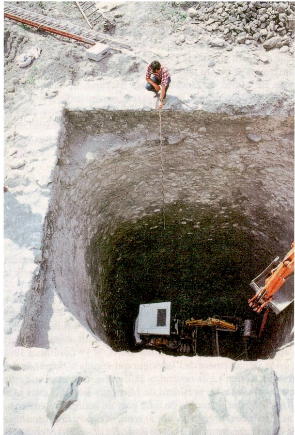
Abb. 17: (Früh-)neuzeitliche und moderne Baubefunde, die nachweislich zur Bevorratung von Schnee und Eis dienten. Die im frühen 19. Jahrhundert errichtete glacière der Société des Glaces du Trient in Martigny VS während der Freilegung (1987).
