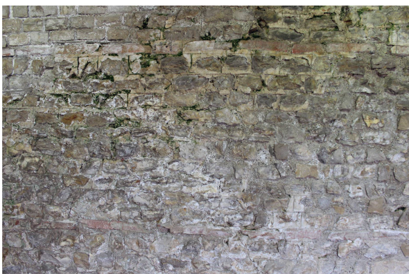
Abb. 17: Augst BL, Taberna (Monumentenrestaurierung 907.2019.01). Noch mehrere Meter hoch erhaltene Rückwand mit starken Veralgungen, Aussinterungen und Salzausblühungen. Reinigungsversuche mit Zustand vor (links) und nach (rechts) dem Anlegen einer Testfläche.
