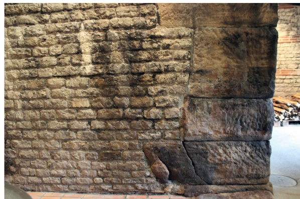
Abb. 5: Augst BL, Schönbühl (Monumentenrestaurierung 903.2019.02). Reinigungstests in der Brotbackstube am Mauerwerk der Stützmauerkonstruktion. Situation vor (links) und nach (rechts) dem Anlegen von Testflächen. Reinigung am Kalksteinmauerwerk. Die Versinterungen liessen sich mithilfe des Heissdampfgeräts praktisch vollständig entfernen.
