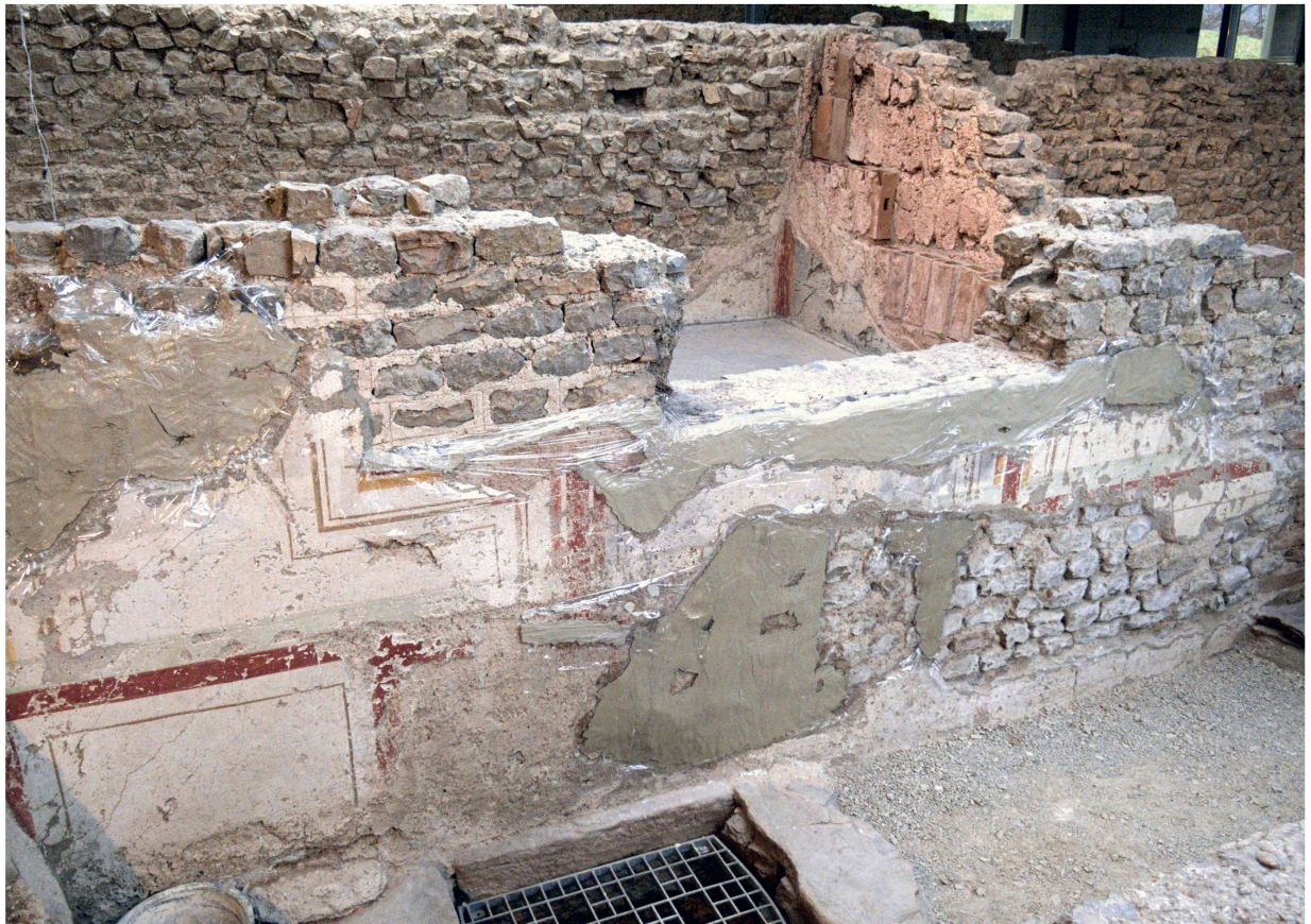
Abb. 23: Kaiseraugst AG, Schmidmatt (Monumentenrestaurierung 917.2019.01). Wandmalerei an Mauer MR 26 in Korridor 5. Die flächigen Ergänzungen aus synthetischem Mörtel, die grosse Teile des originalen Befunds verdeckt haben, sind teilweise entfernt. Das Mauerwerk gewinnt so wieder an Authentizität und der Feuchtigkeitsaustausch ist besser gewährleistet.
