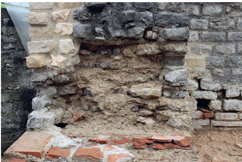
Abb. 12: Augst BL, Forum (Monumentenrestaurierung 906.2019.01). Treppenhaus der Basilica. Dasselbe Gewände mit blossliegendem antikem Mauerwerk, nach Entfernen der modernen Zementrestaurierungen, hier von vorne.
