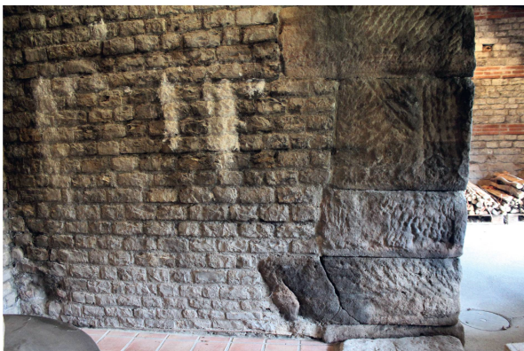
Abb. 5: Augst BL, Schönbühl (Monumentenrestaurierung 903.2019.02). Reinigungstests in der Brotbackstube am Mauerwerk der Stützmauerkonstruktion. Situation vor (links) und nach (rechts) dem Anlegen von Testflächen. Reinigung am Kalksteinmauerwerk. Die Versinterungen liessen sich mithilfe des Heissdampfgeräts praktisch vollständig entfernen.
