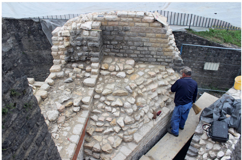
Abb. 15: Augst BL, Forum (Monumentenrestaurierung 906.2019.01). Treppenhaus der Basilica. Seitenzone des Kanals in der Fortsetzung nach Osten, schützende Übermauerung nach Abschluss der Restaurierung; das Gewände des Türdurchgangs in der linken Bildhälfte ist noch nicht fertiggestellt.
