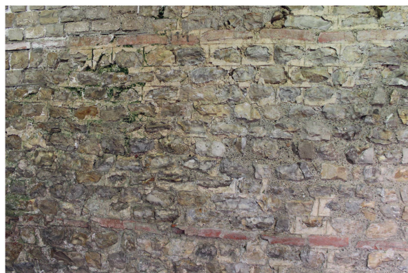
Abb. 17: Augst BL, Taberna (Monumentenrestaurierung 907.2019.01). Noch mehrere Meter hoch erhaltene Rückwand mit starken Veralgungen, Aussinterungen und Salzausblühungen. Reinigungsversuche mit Zustand vor (links) und nach (rechts) dem Anlegen einer Testfläche.
