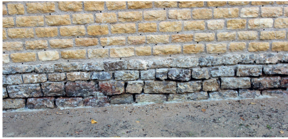
Abb. 8: Augst BL, Amphitheater (Monumentenrestaurierung 905.2019.01). Restaurierung und Erneuerung der rekonstruierten Podiumsmauer. Von den Zementfugen befreites Originalmauerwerk, bereit für die Neuverfugung mit Kalkmörtel.
