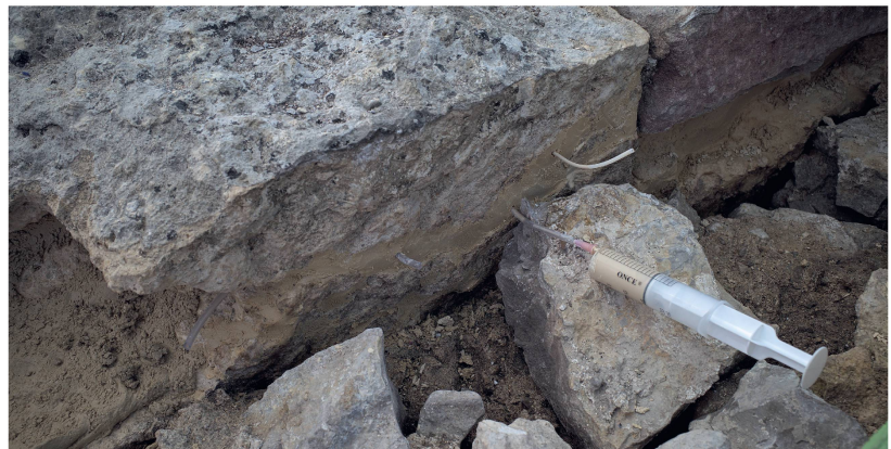
Abb. 3: Augst BL, Schönbühl (Monumentenrestaurierung 903.2019.01). Konservierung eines originalen Stereobatenquaders des Schönbühltempels. Schliessen der Risse durch Injektionen.
