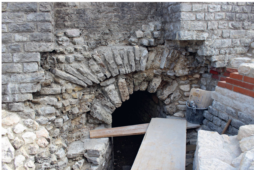
Abb. 15: Augst BL, Forum (Monumentenrestaurierung 906.2019.01). Treppenhaus der Basilica. Seitenzone des Kanals in der Fortsetzung nach Osten, schützende Übermauerung nach Abschluss der Restaurierung; das Gewände des Türdurchgangs in der linken Bildhälfte ist noch nicht fertiggestellt.
