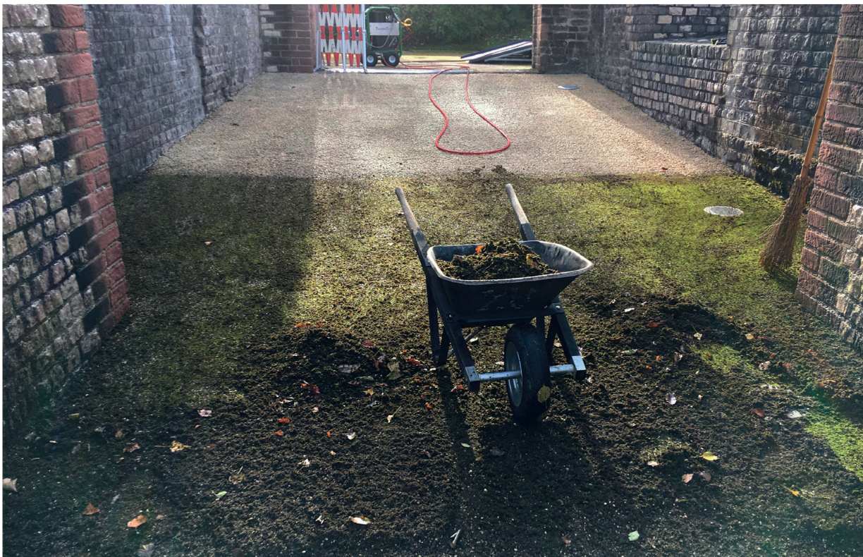
Abb. 42: Augst BL, Theater (Monumentenrestaurierung 924.2020.02). Umfassende Reinigungsarbeiten in den vomitoria und den aditus. Halb fertiggestellte Reinigung im südlichen aditus maximus. Die Moosschicht auf dem Sickerbodenbelag war hier so dick, dass sie vorgängig zur Reinigung mit dem Heissdampfgerät grob von Hand entfernt werden musste. Auch hier ist das Resultat der mit vergleichsweise geringem Aufwand verbundenen Unterhaltsmassnahme eindeutig (vgl. obere Bildhälfte).
