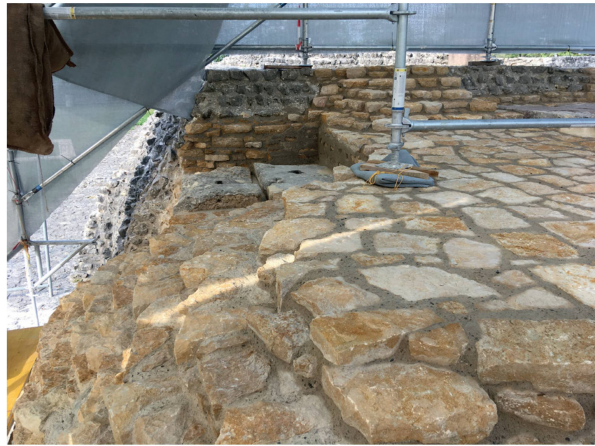
Abb. 9: Augst BL, Schönbühl (Monumentenrestaurierung 903.2020.02). Restaurierung der Stereobatenquader und der SE-Ecke des Tempelpodiums. Südliches in situ erhaltenes Quaderfundament nach Abschluss der Konservierungsarbeiten. Die Oberfläche des noch erhaltenen Kalksteinpodiums wurde mit einer neuen Verschleisschicht abgedeckt, deren Neigung das Oberflächenwasser effizienter von den Stereobaten ableiten soll. Angesichts der knappen Platzverhältnisse zum Aufführen der schützenden Übermauerungen musste die Oberfläche beim südlichen Quaderfundament als Negativform eines heute verschwundenen Quaders ausgebildet werden und dient gleichzeitig als Lesehilfe.
