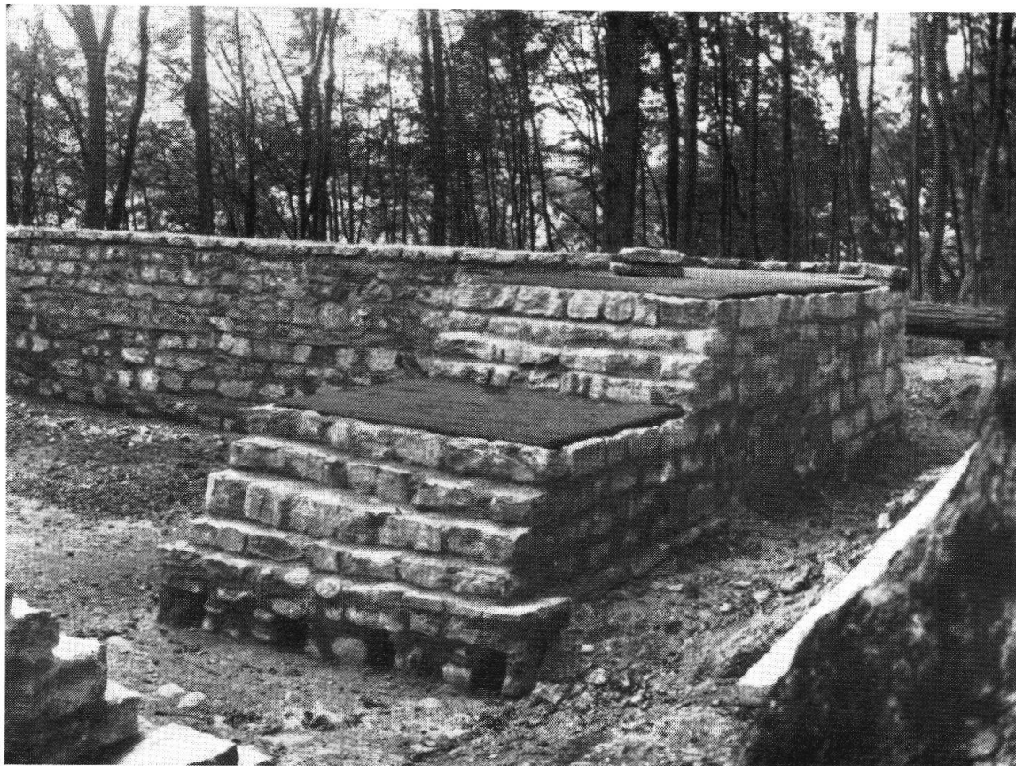
Taf. XV, Abb. 2. Rheinfelden, Pferrichgraben. Spätromischer Wachturm, während der Konservierung (S. 149) Aus V. J. z. Schwarzwald 1940, Heft 3
