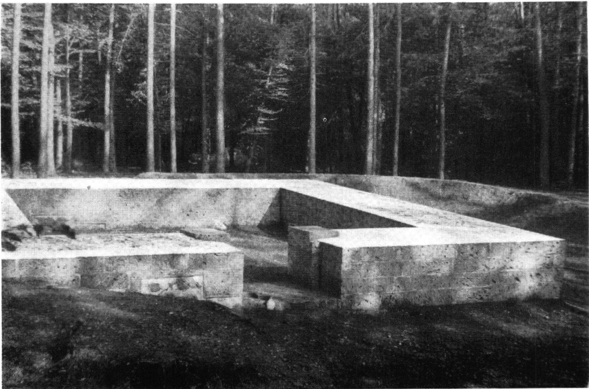
Taf. XXI, Abb. 1. Ellikon a. Rh. Römische Warte mit Tuffsteinverkleidung, fertig konserviert (S. 122)
