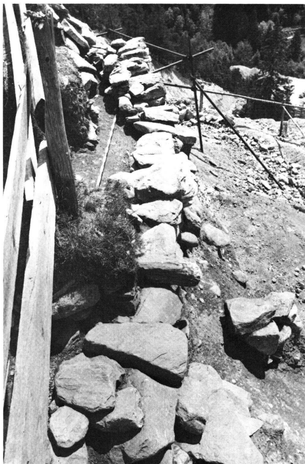
Abb. 41. Scharans, Spundas, GR. 1978. Feld 1/2, Süderweiterung, nach dem 2. Abstich. Trockenmauerkonstruktion M 1. (Foto AD GR.)
