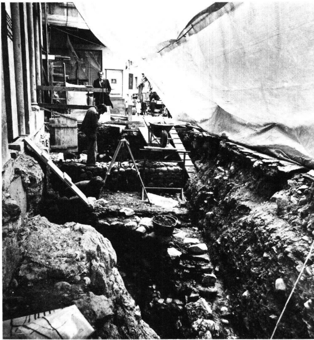
Abb. 40. Zürich ZH. Storchengasse zwischen den Häusern Nr. 8/13. Der durch die Befunde im Hausinnern ausgelöste archäologische Voraushub brachte erste zusammenhängende Grundrisse römischer Bauten ausserhalb des Lindenhofkastells zum Vorschein: Im Vordergrund das aufgehende Mauerwerk eines Zentralbaus. Im Mittelgrund die Süd-wand eines grösseren Gebäudes, welches rittlings über einer älteren Strassenkofferrung liegt.
