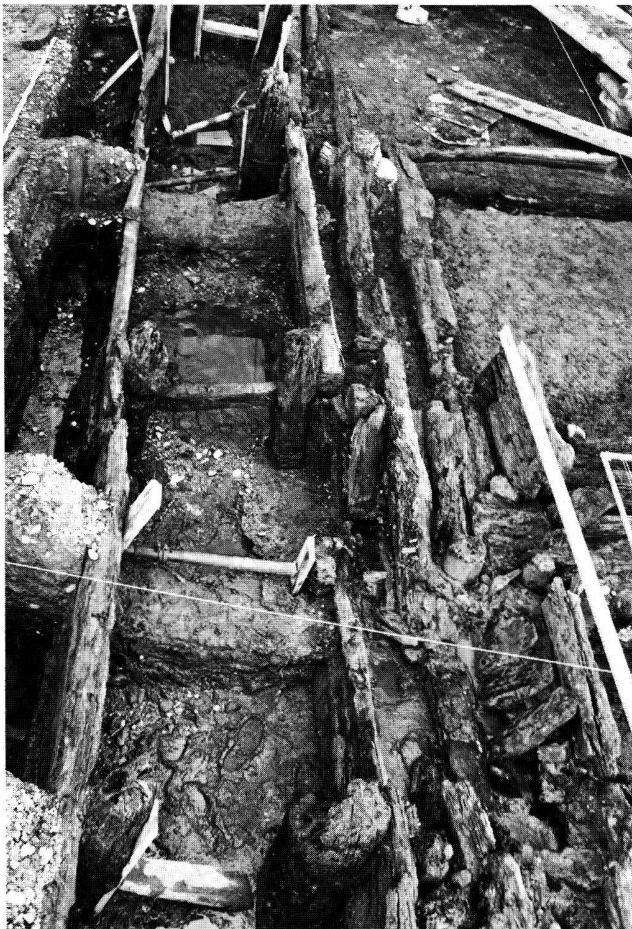
Abb. 57. Winterthur, Oberwinterthur ZH, Unteres Bühl. Grosser Abwasserkanal der 1. und 2. Bauperiode.
