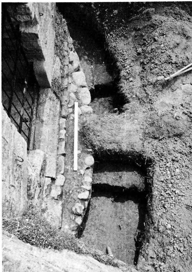
Abb. 50. Stein a.Rhein SH. Spät Römisches Kastell auf Burg. Blick von der südlichen Kastellmauer auf das runde Fundament des Südostturmes. Auf diesem Fundament Reste der einen Seitenfläche des im Plan auf einem regelmässigen Siebeneck basierenden Turmes. Die Mauerverblendung oberhalb der Tuffsteinschwelle der Ausfallpforte ist seit 1900 mehrfach überarbeitet worden.
