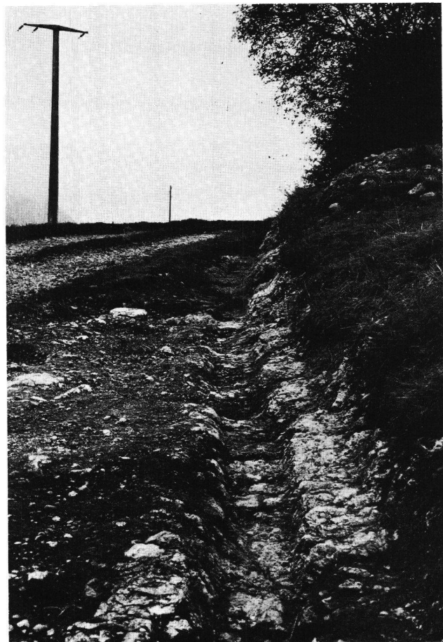
Fig. 81. Lignerolle VD. Voie à ornières. Ornière amont taillée dans le calcaire.
