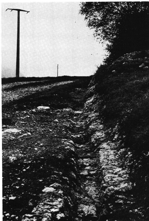
Fig. 81. Lignerolle VD. Voie à ornières. Ornière amont taillée dans le calcaire.
