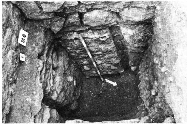
Fig. 62. Yverdon-les-Bains VD, Castrum romain. Empreintes des pieux du coffrage dans la maçonnerie. Photo M.-J. Colomb.
