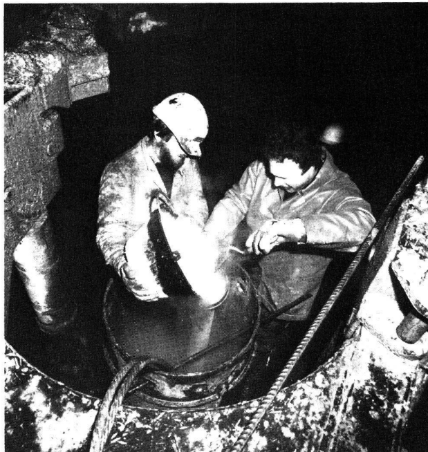
Abb. 2. Das Trockeneis wird in das Sondierrohr eingefüllt.
