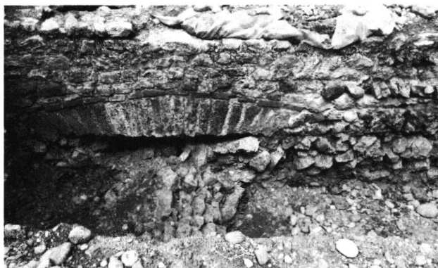
Fig. 10. Le mur sud du portique ou corridor M présente un dispositif de décharge à l'endroit où il croise le tracé du collecteur nord-sud: sur un pont de planches, dont les traces subsistent dans le mortier, a été disposée une rangée de claveaux de tuf surmontés d'une assise de briques.
