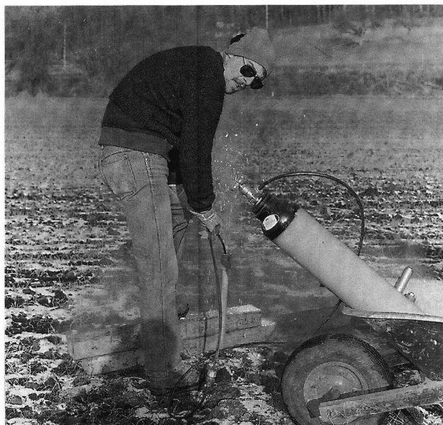
Abb. 1. Das eingerammte Sondierrohr wird mit flüssigem CO 2 gekühlt.
