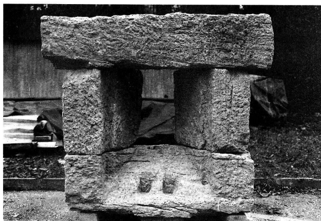
Fig. 16. Avenches VD, Insula 7. Les éléments en grès coquillier de la lucarne du bâtiment central remontés; dimensions de l'ouverture extérieure: 53 × 21 cm. 3 e s. ap. J.-C.
