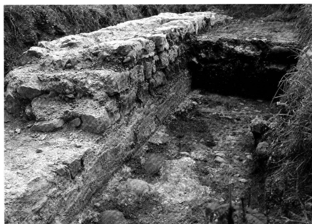
Abb. 3. Jona-Kempraten, Parz. 4239. MR 8 mit Rest von Wandverputz am Fuss der aufgehenden Mauerpartie. In der Fläche am Fuss der Mauer Kieselrollierung (Gehniveau). Blick von NW. Photo KA SG.
