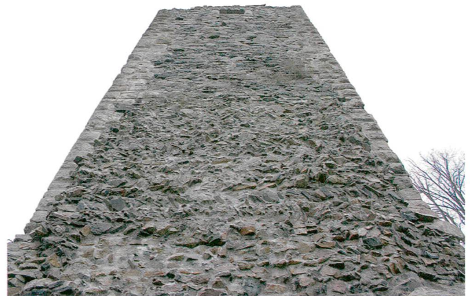
Abb. 25. Laufenburg-Schlossberg. Die Südfront besteht im unteren Bereich aus einer Mauer im Ährenverband. Foto F. Tortoli.
