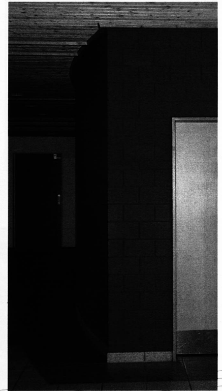
Lange, gerade Flure in öffentlichen Gebäuden sollten bereits beim Bau leicht gerundet werden
