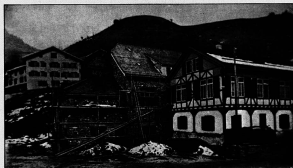
Die Turnhalle im Rohbau 1909
