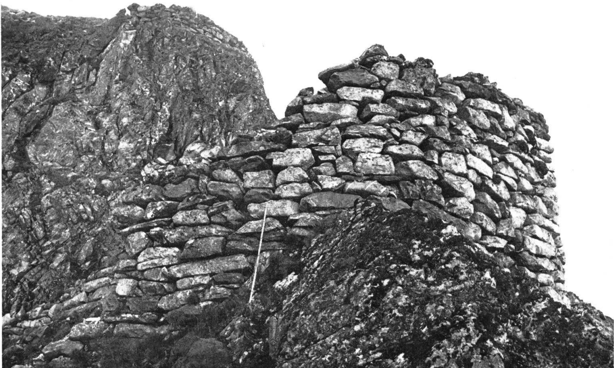
Fig. 16: Löttschen-Nordseite: Wegkehre in der "Unteren Felswand" (AERNI 1971: Tafel 5, Ziffer 26, A 35). Überrest einer Wendeplatte aus den Jahren 1696/97. Die Höhe beträgt im Maximum noch 3 m. Die Stützmauer besteht aus einem hammerrechten Schichtenmauerwerk, dessen Aussensteine ursprünglich mit Mörtel verbunden waren. Vergleichsstrecke 2 m. Aufnahme vom 8.9.1961. Anlässlich der Begehung vom September 1969 musste ich feststellen, dass die Mauerecke im rechten Bildteil zwischen 1964 und 1969 abgestürzt ist. Standort: 621 370 / 140 975 / 2350 m; Bildmitte Az 2600 A ‰. LK 264
