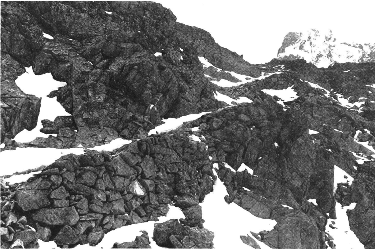
Fig. 4: Lötschen – Nordseite: Weg durch die “Obere Felswand” (AERNI 1971: Tafel 5, Ziffer 33, A34): Im Mittelgrund gebauter Weg aus der Zeit vor 1698, mit bautechnisch und topographisch ausgeglichener Steigung. Im Hintergrund des Ferden-Rothorn. Wegoberfläche mit Steilrandpflaster, bergseits in Blockpflaster und Feinmaterial übergehend, Wegbreite 2,2 m und mehr. Stützmauern aus Bruchsteinen in wildem Verband und ungeordneter Lagerung der Steinlängsachsen. Stadort: 621 110 / 140 075 / 2600 m; Bildmitte Az 3600 A ‰. LK 264
