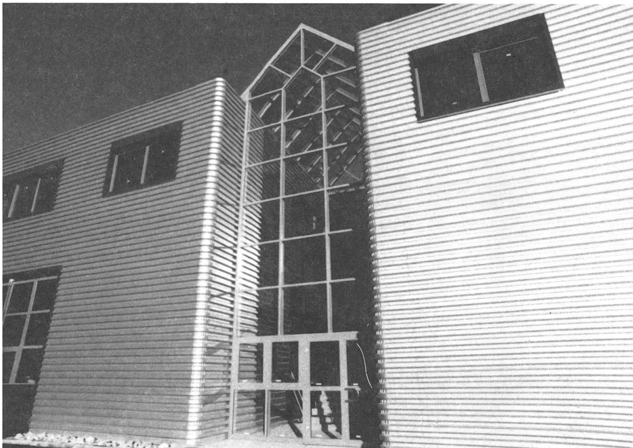
Photo 1: Le nouveau centre industriel «Cicour» à Courtelary.
