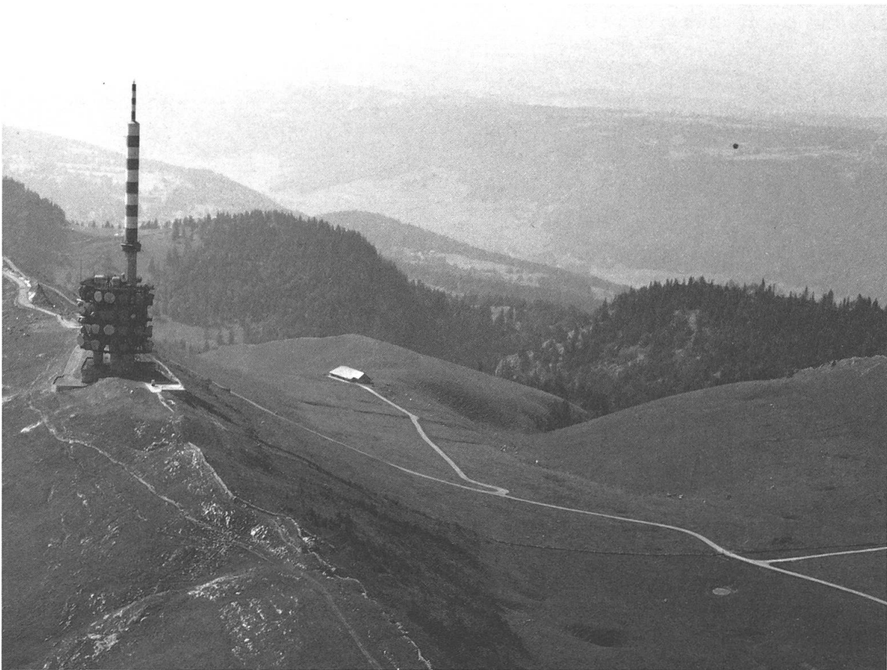
Photo 3: Chasseral – les chaînes méridionales sont les plus hautes (photo aérienne: Raymond BRUCKERT, Plagne)
