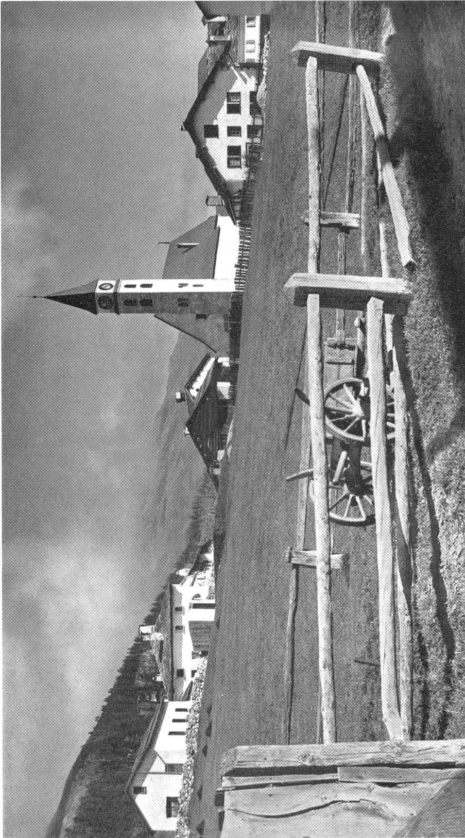
Foto 20a/b Verschiedene Dachformen in Silvaplana. Altes Pfettendach beim Stall, Steildach mit Knickung auf Kirche und Kirchturm. Pyramidisches Dach nach italienischer Art beim zweiten Haus von links. Man beachte auf der Ansicht (b) die schöne Gesamtwirkung der mit Fexer Glimmerschiefer eingedeckten Plattendächer
