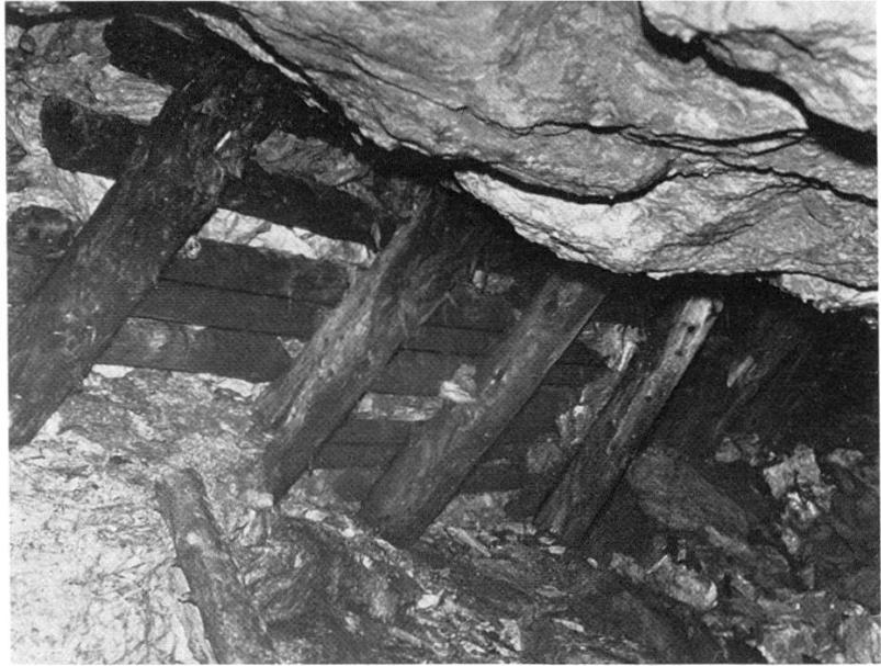
15 Mit Zimmerung abgestützter Versatz im Bergwerk Ursera.
