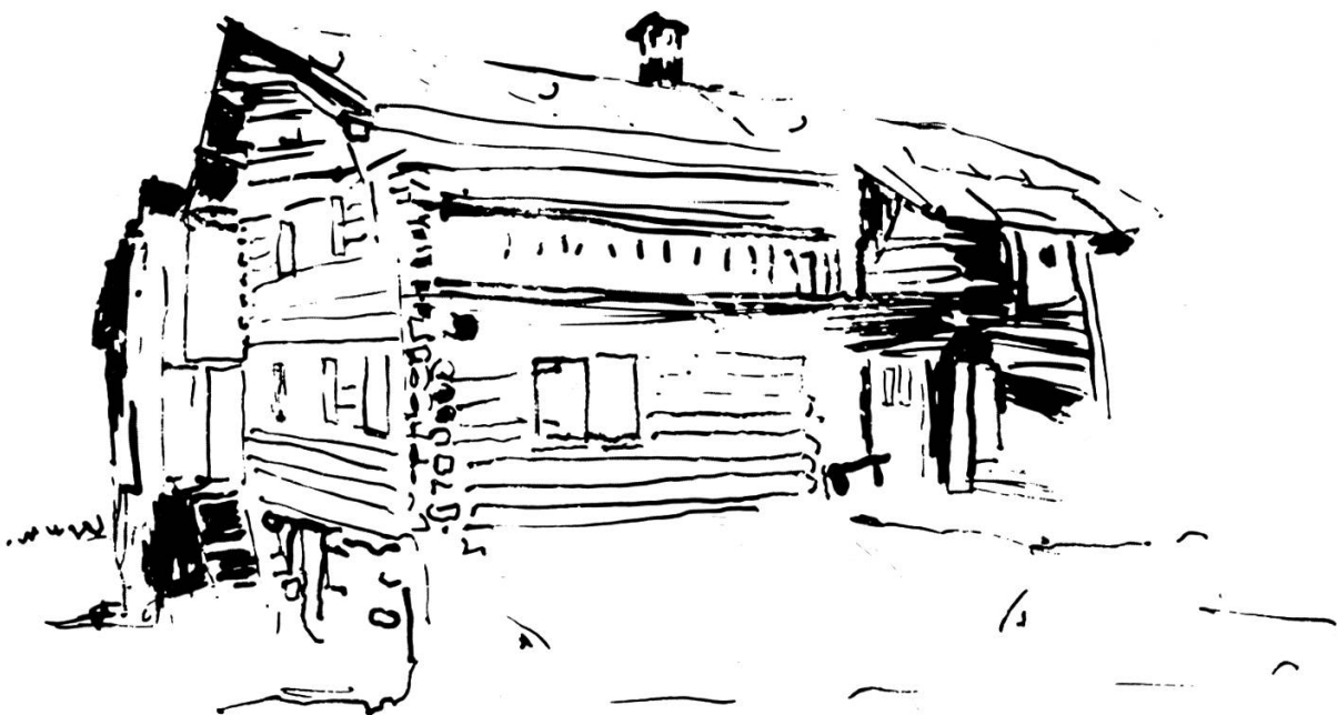
Inneralpines Blockhaus in Lunden. Wohnhaus und Stall sind getrennt. Im Wohnhaus vorne ebenerdig Stube, dahinter Nebenstube. Bergseits Vorhaus mit gemauertem Küchenteil.
